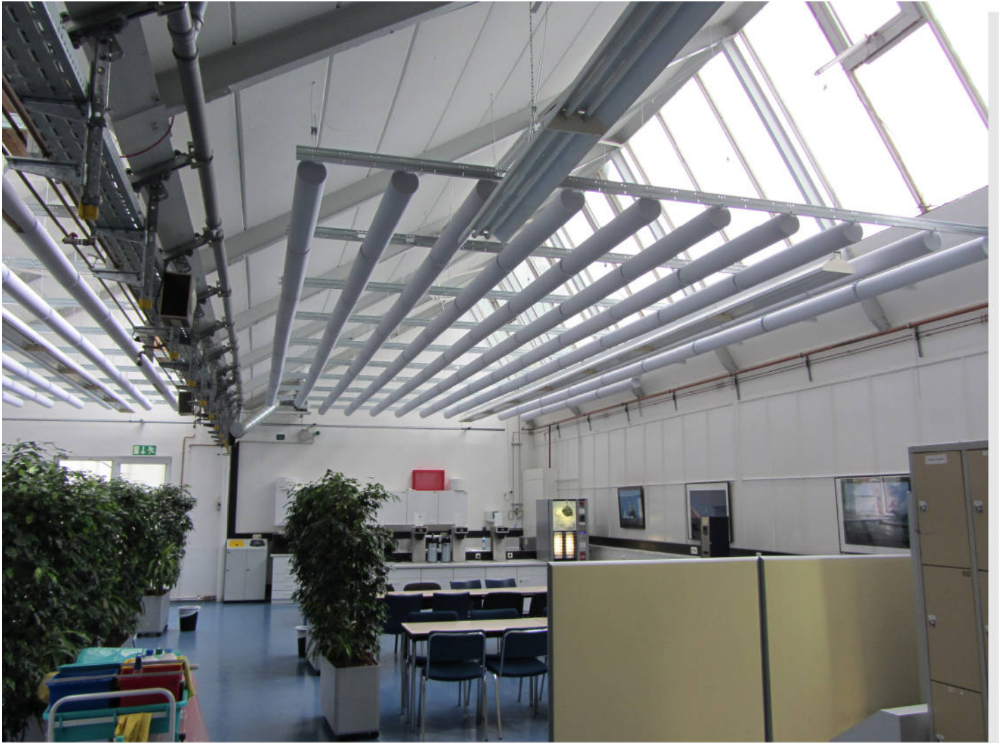
WILLBRANDT Absorber Zylinder mit T24-Schienen-System
